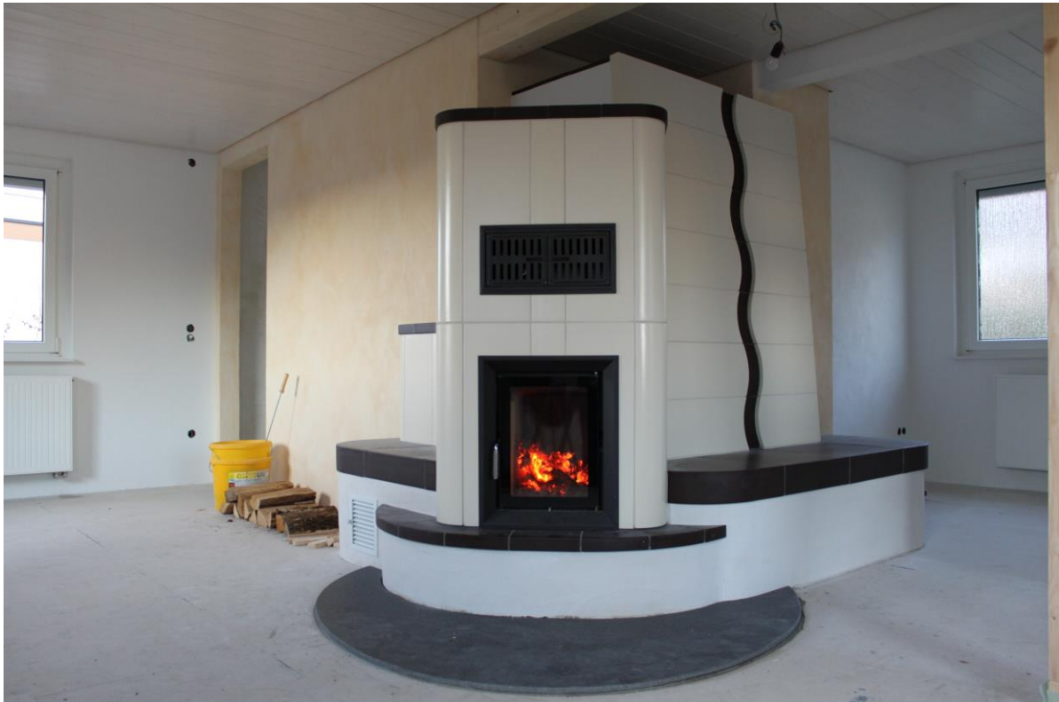
Brunner Kachelofen mit Wasserwärmetauscher
