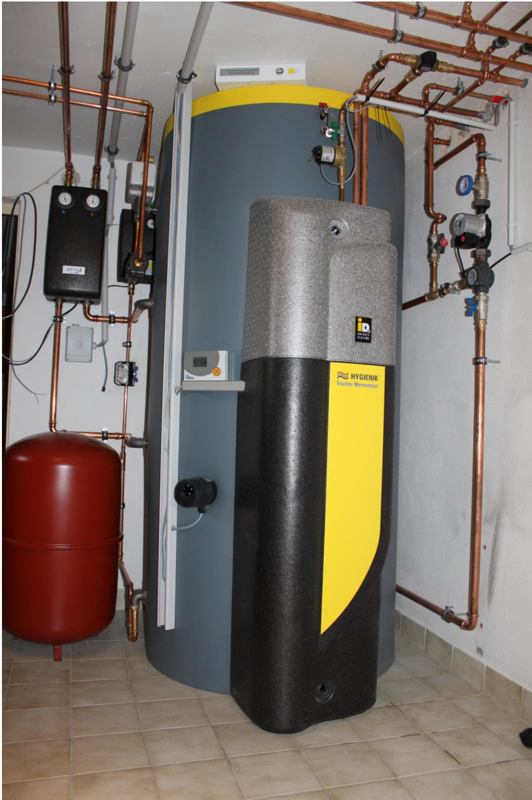
Hygienik Frischwasserspeicher als Herzstück des Systems
