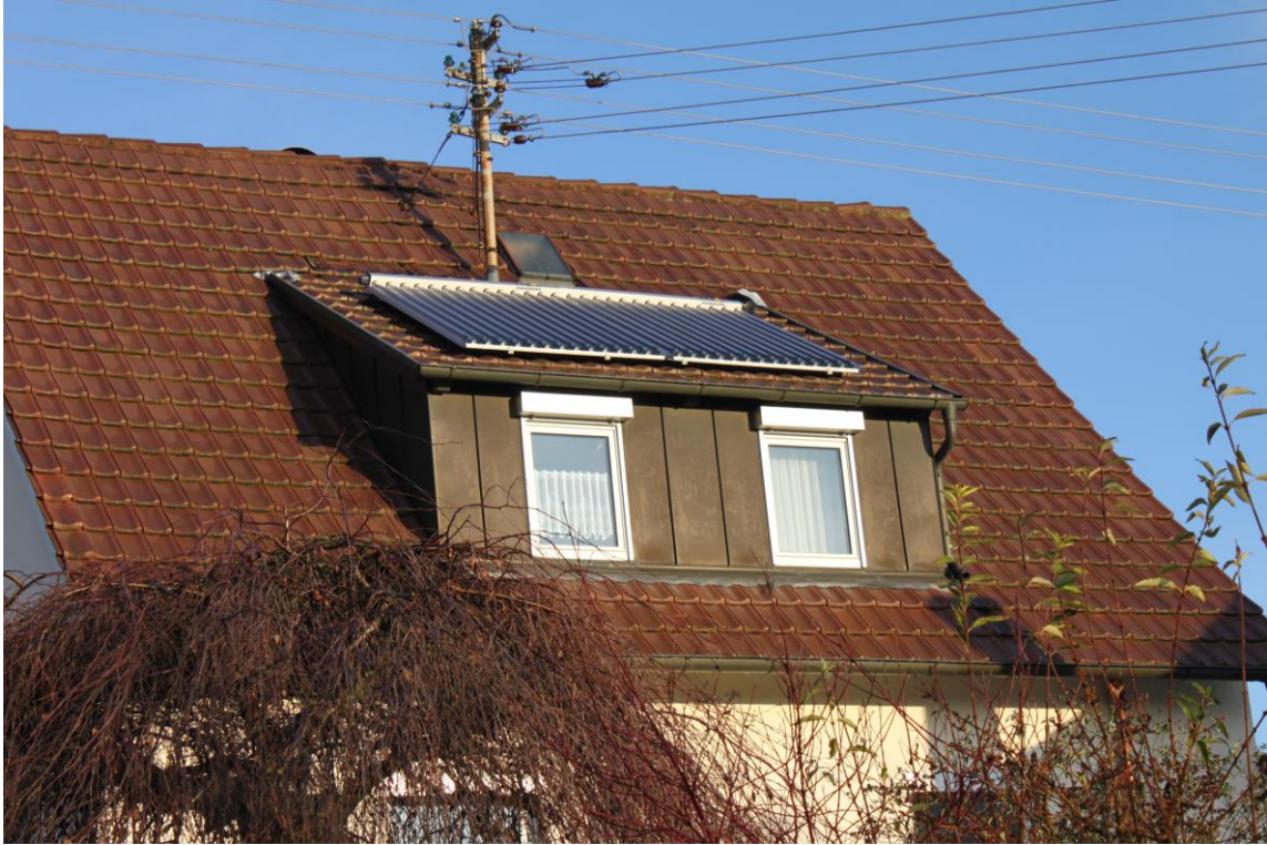
Thermische Solaranlage System Paradigma Aqua
